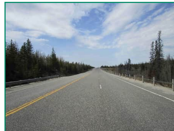
GWP 5151-21-00 (sud): L'autoroute 11 à partir du chemin Sand Dam vers le nord sur 13,8 km jusqu'au chemin Ellsmere
